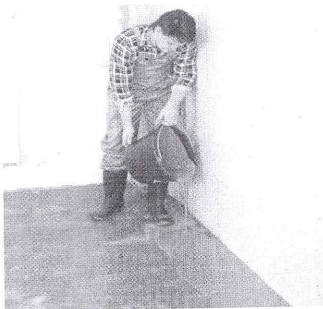
Рисунок 14 – Укладка (а) и распределение (б) самонивелирующейся смеси по поверхности основания теркой
