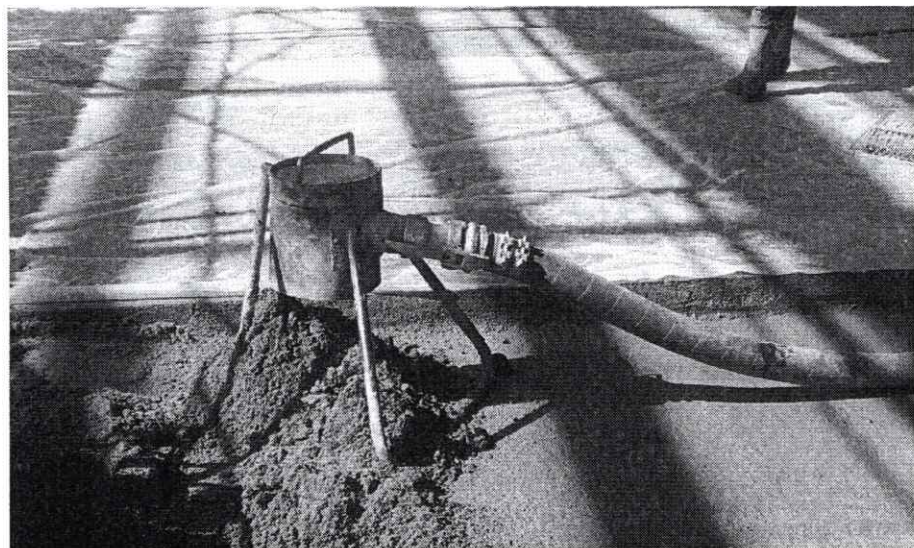
Рисунок 13 – Укладка растворной смеси через насадку-гаситель
