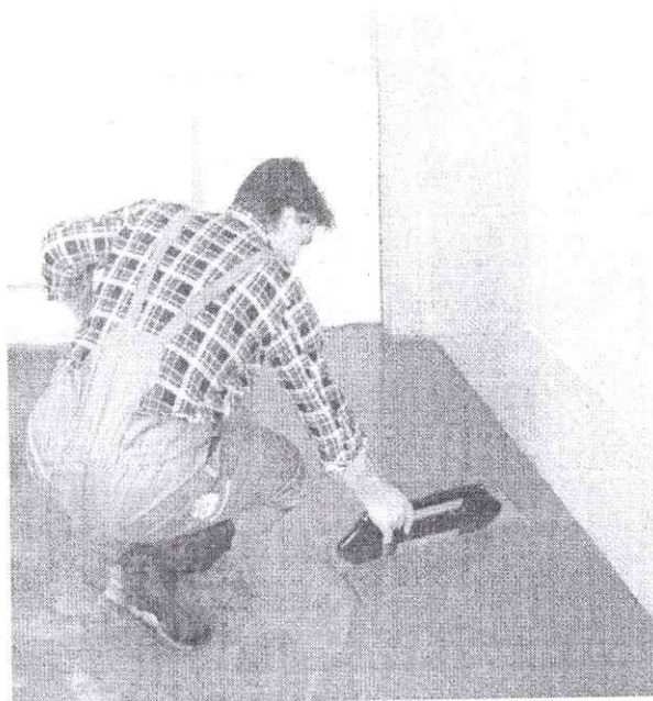
Рисунок 14 – Укладка (а) и распределение (б) самонивелирующейся смеси по поверхности основания теркой
