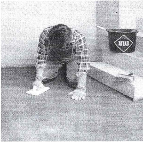
Рисунок 12 – Затираание (а) и заглаживание (б) поверхности стяжки
