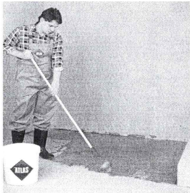
Рисунок 8 – Грунтование поверхности основания
