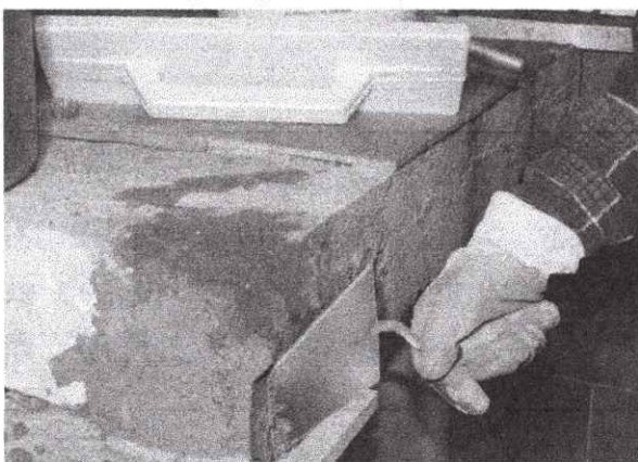
Рисунок 11 – Нанесение ремонтного слоя
