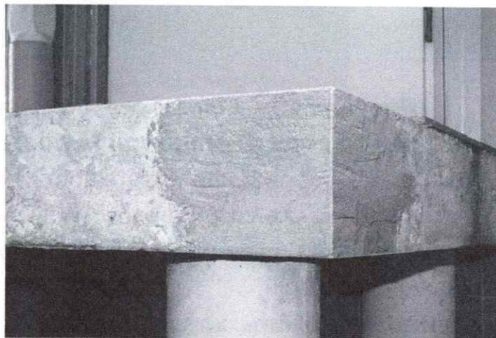
Рисунок 12 – Зашпатлеванная поверхность
