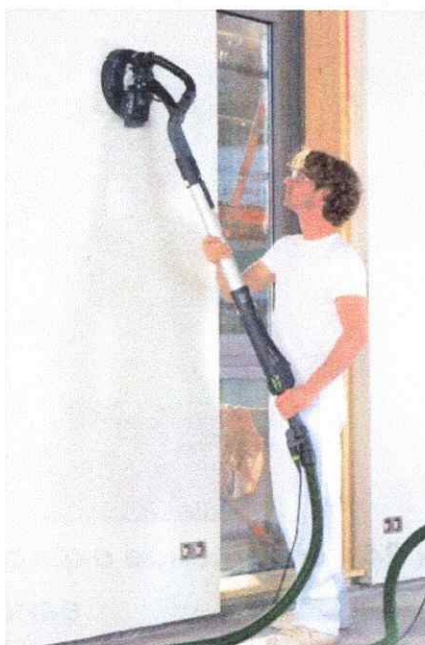
Рисунок 31 – Механизированное шлифование
