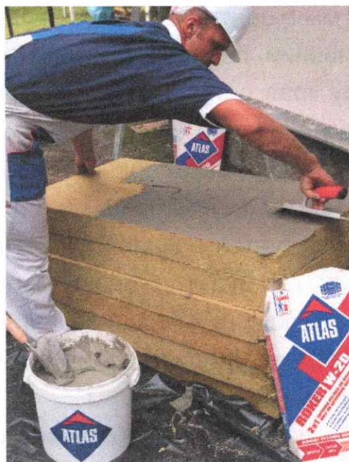
Рисунок 11 – Нанесение клеевого состава на теплоизоляционную плиту сплошным методом
