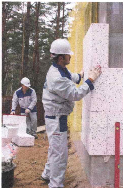
Рисунок 12 – Перевязка плит на углу здания
