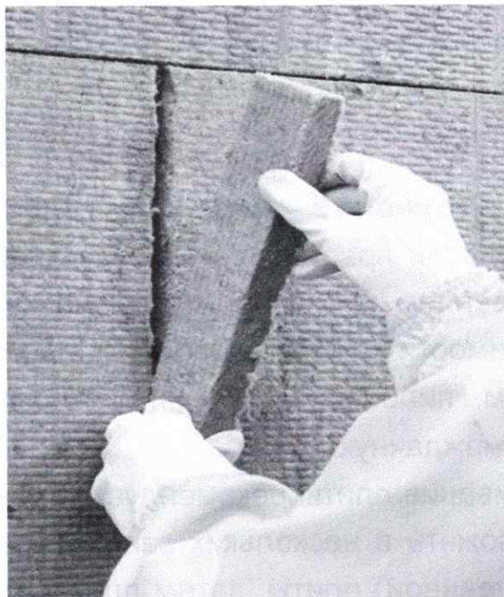
Рисунок 14 – Заделка зазоров между теплоизоляционными плитами
