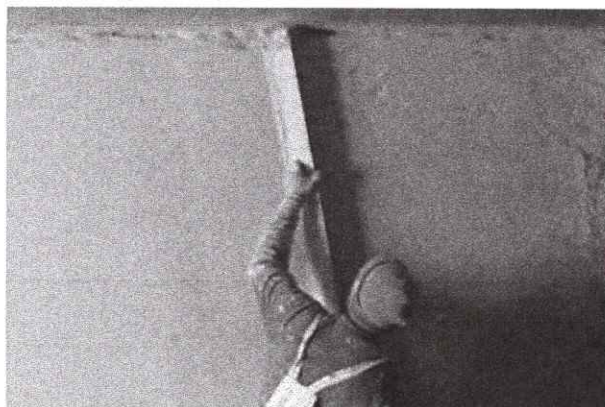
Рисунок 11 – Предварительное выравнивание «h»-образной рейкой
