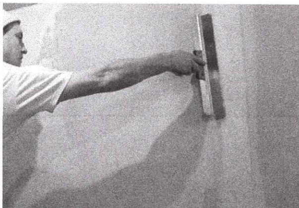
Рисунок 12 – Окончательное выравнивание поверхности шпателем
