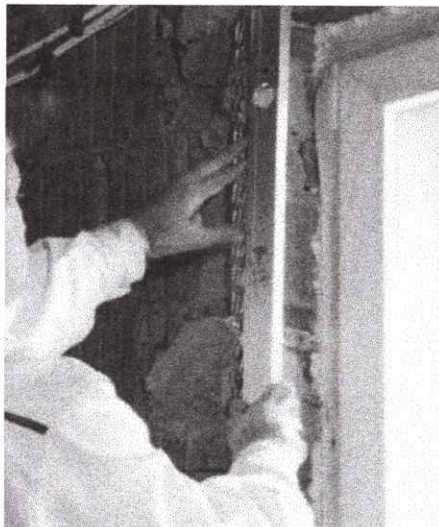
Рисунок 9 – Установка защитного профиля
