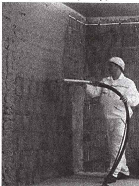
Рисунок 10 – Нанесение штукатурного раствора на стену
