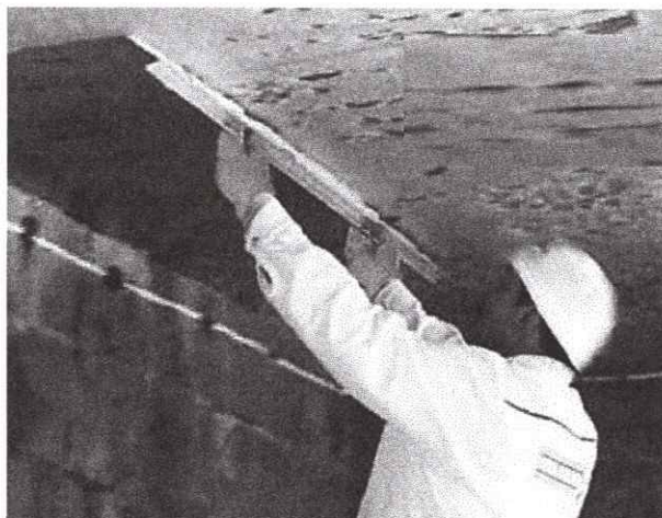
Рисунок 16 – Предварительное выравнивание поверхности потолка
