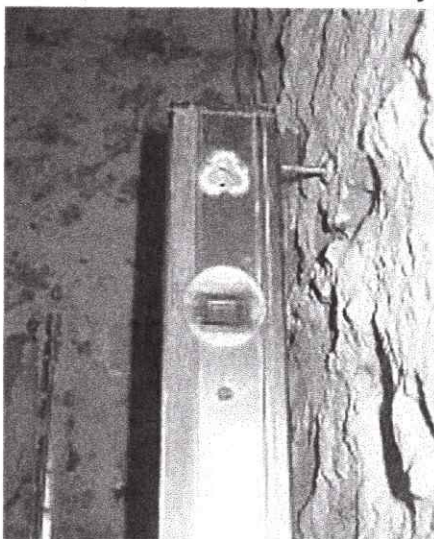
Рисунок 6 – Провешивание стен уровнем с правилом
