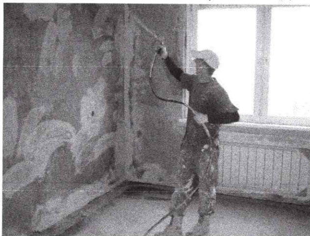
Рисунок 6 - Нанесение грунтовочного состава механизированным способом
