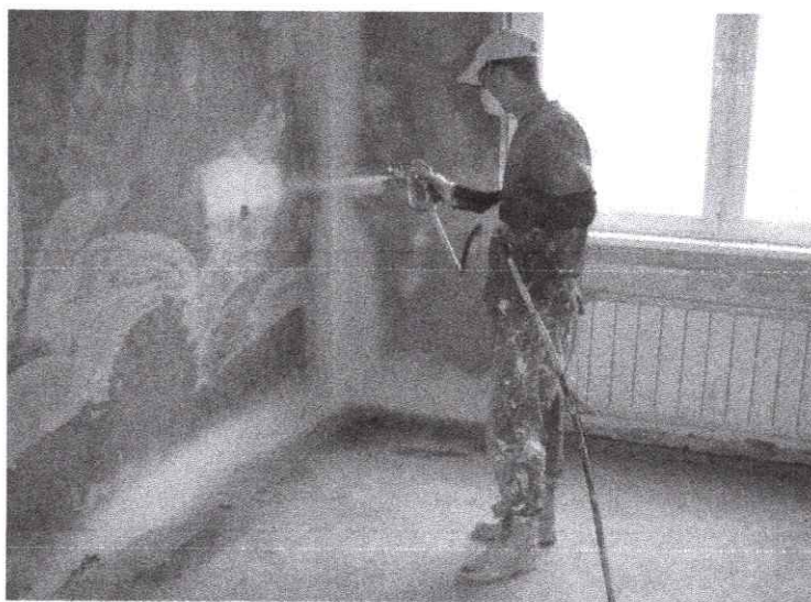
Рисунок 7 - Нанесение шпатлевочного состава механизированным способом
