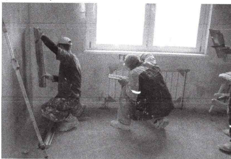
Рисунок 8- Выравнивание шпатлевочного состава шпателями
