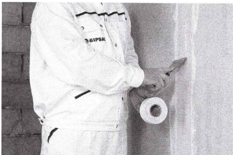
Рисунок 4.5– Заделка швов
