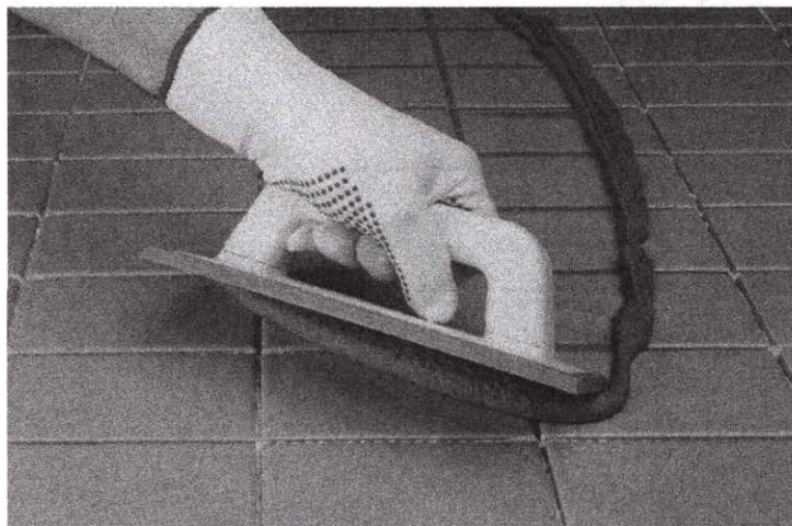
Рисунок 4.9 – Заполнение швов при укладке плитки (плит)
